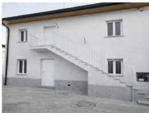
COLNAGO: Tre locali al piano terra e piano primo, ristrutturati e con box
